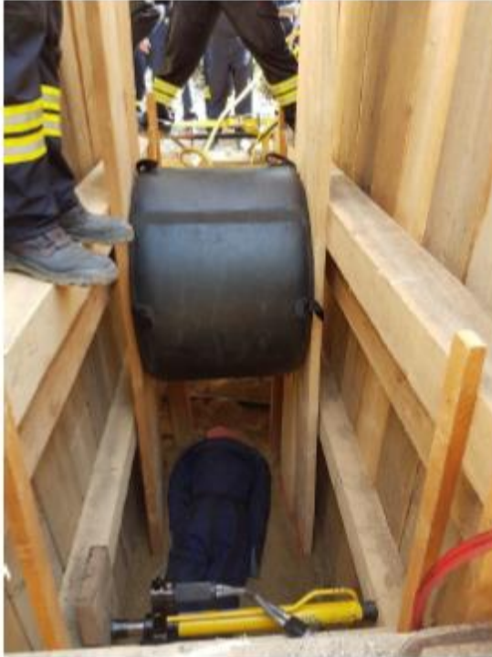
Abb. 16: Sicherung durch Bohlen und Hebekissen \leq 1 bar
