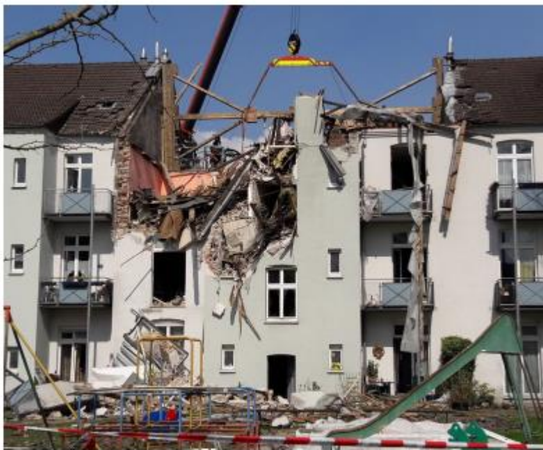
Abb. 13: Sprengwerk für eine Giebelwandabstützung, Quelle: Herr Pletscher (HLFS)
