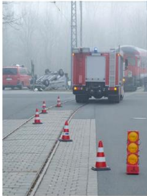
Sperrung einer Fahrspur mit Verkehrsleitkegeln und Warnleuchten
