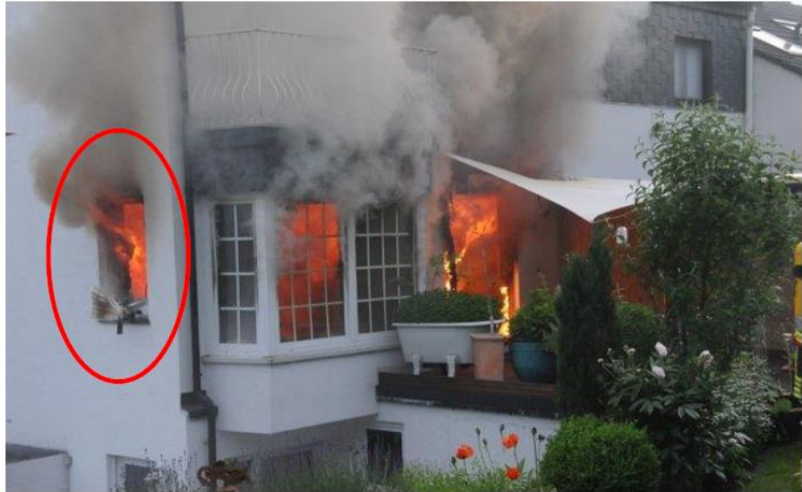
Abbildung 10 - Seitenfenster ist sowohl Abluft (oben - Flammen) als auch Zuluftöffnung (unten), Rossbach, Wuppertal, ecomed-Storck GmbH
