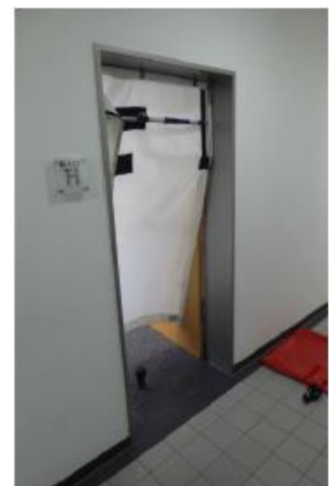
Abbildung 26 Neben der Ventilation verhindert der mobile Rauchverschluss ein unkontrolliertes Ausbreiten von Rauch im Gebäude. [IdF NRW]
