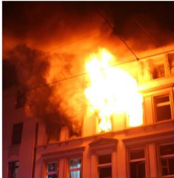
Abbildung 5: Vollbrandphase: über den Zustand der Raumdurchzündungsphase hinaus ist hier das komplette Raumvolumen mit Flammen gefüllt. (Foto: Fichte, Wuppertal, ecomed-Storck GmbH)
