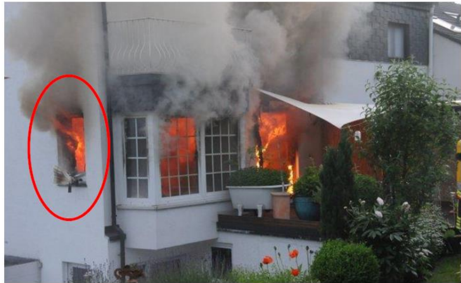
Abbildung 10 - Seitenfenster ist sowohl Abluft (oben - Flammen) als auch Zuluftöffnung (unten), Rossbach, Wuppertal, ecomed-Storck GmbH
